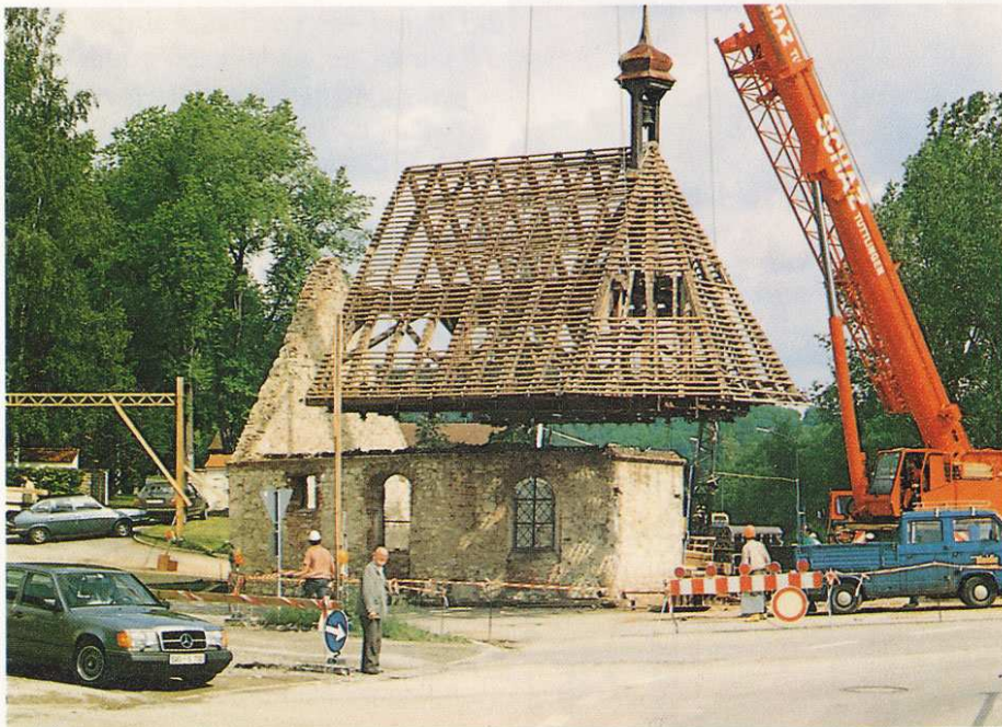
Dachabnahme mittels Großkran
